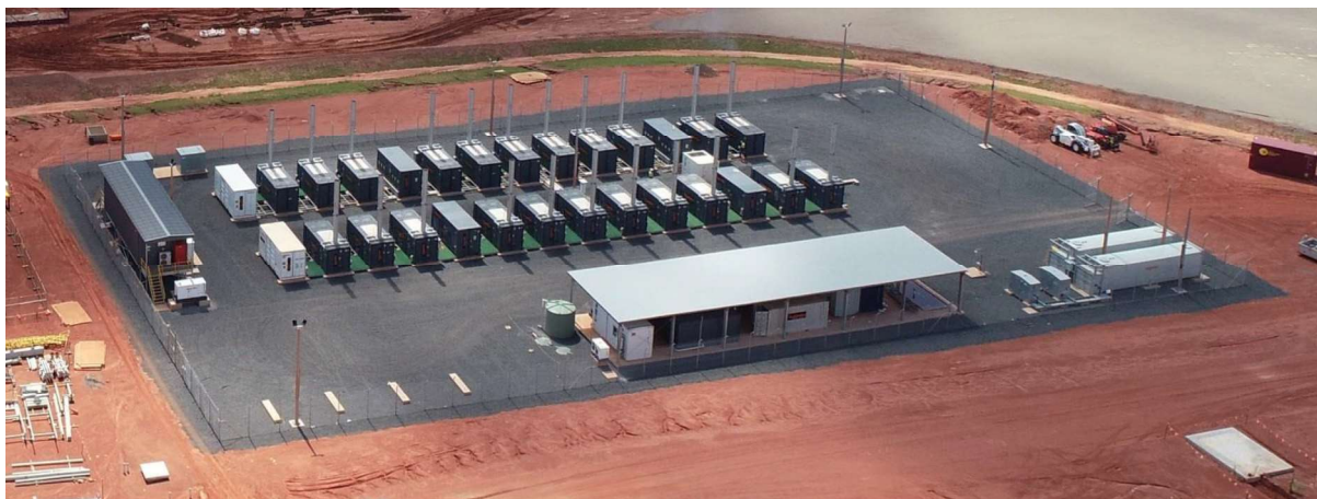
Figure 2.27 Exemple de centrale électrique minière à générateurs en conteneurs
